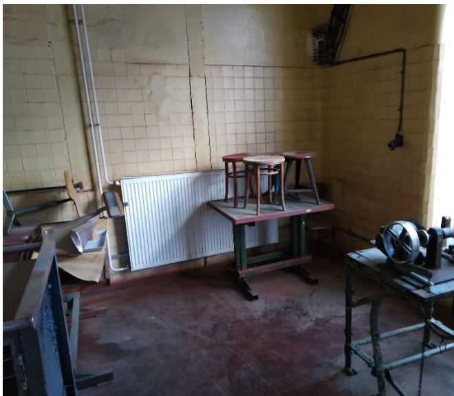
Poloprevádzkové pracovisko - pred úpravou
